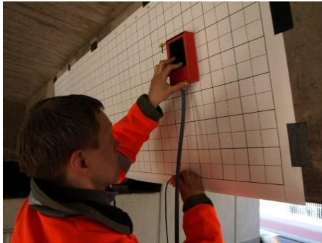
Abb. 1: Längsspanngliedortung an einem Brückenbalken mit Messschablone
