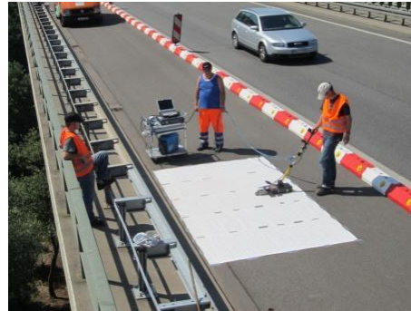
Abb. 2: Querspanngliedortung auf einer Fahrbahnplatte mit Messschablone
