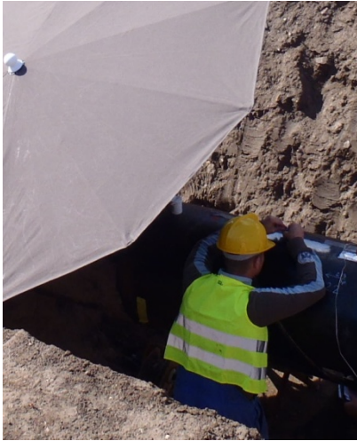
Bild 8. Ultraschallmessungen an einer Gashochdruckleitung
