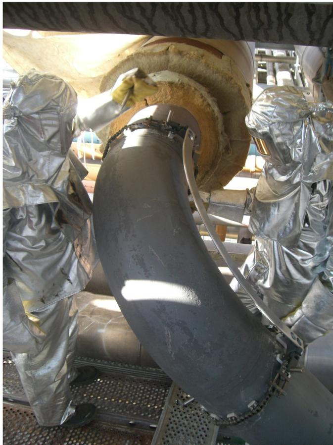
**Abb. 9:** Abisolieren und Montage des Manipulators im Prüfbereich
