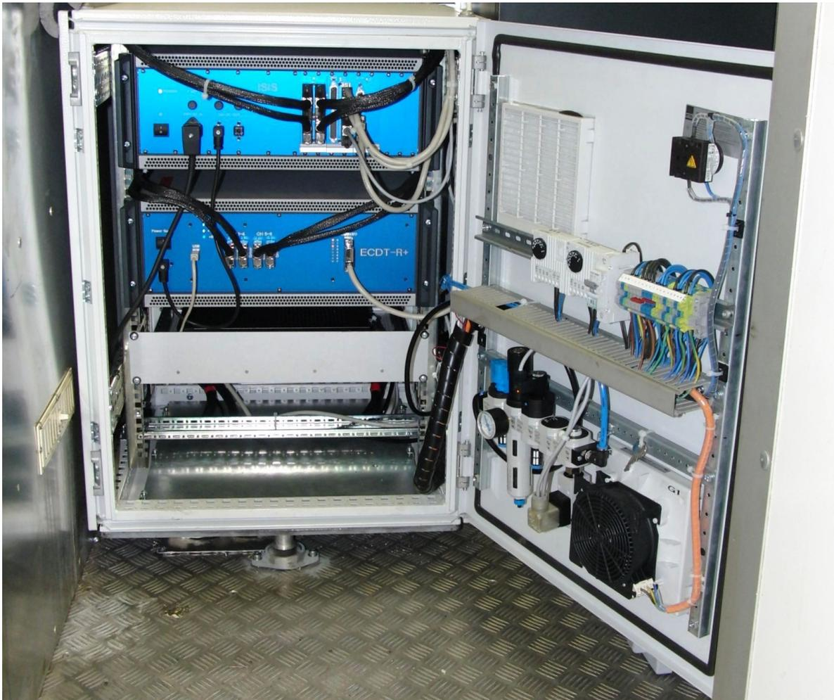
Abbildung 1: 19"-Schrank mit ISIS-Gerät (oben), Wirbelstromprüfgerät (Mitte) und Druckluftaufbereitung für den Sondenträger (Tür)
